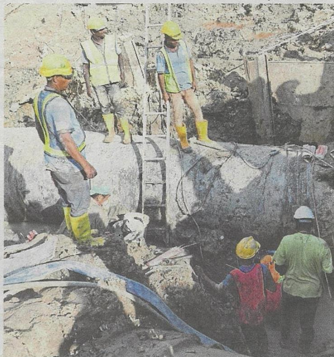
Kerja membaik pulih paip utama yang pecah di tapak WCE Banting-Taipung, semalam.
